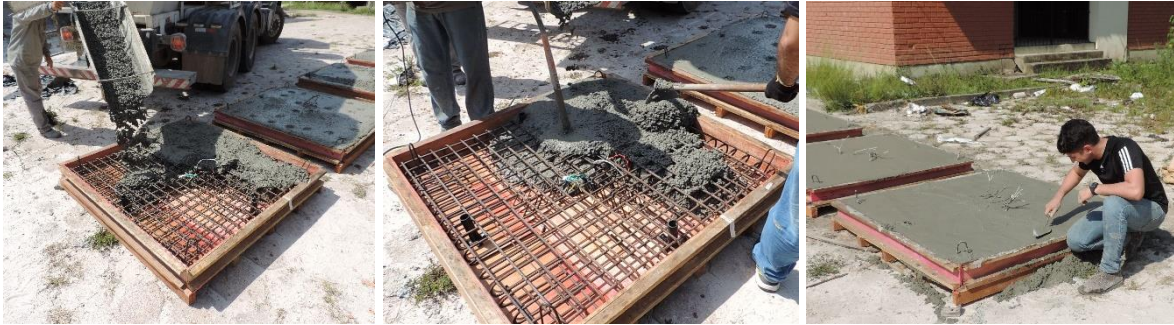
Figura 5.4 – Concretagem das lajes
