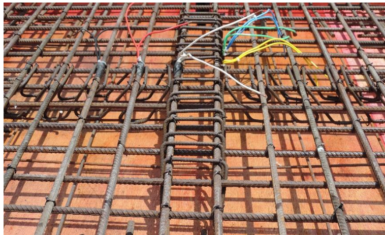
Figura 4.17 – Vista ampliada dos estribos na laje L2
